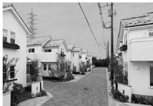
写真-2 宅地内建設柱の事例 2)
