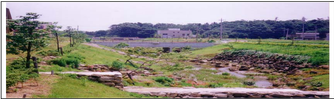
写真1 守谷東地区雨水幹線8号の整理前後
