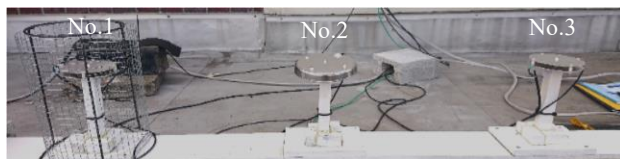
図.2 足利大学4号館屋上に設置したセンサー群
