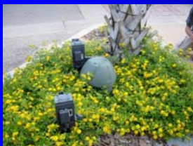
イベントインフラとして電源、スピーカーなどを植栽部分に整備 (リーズバーク)
