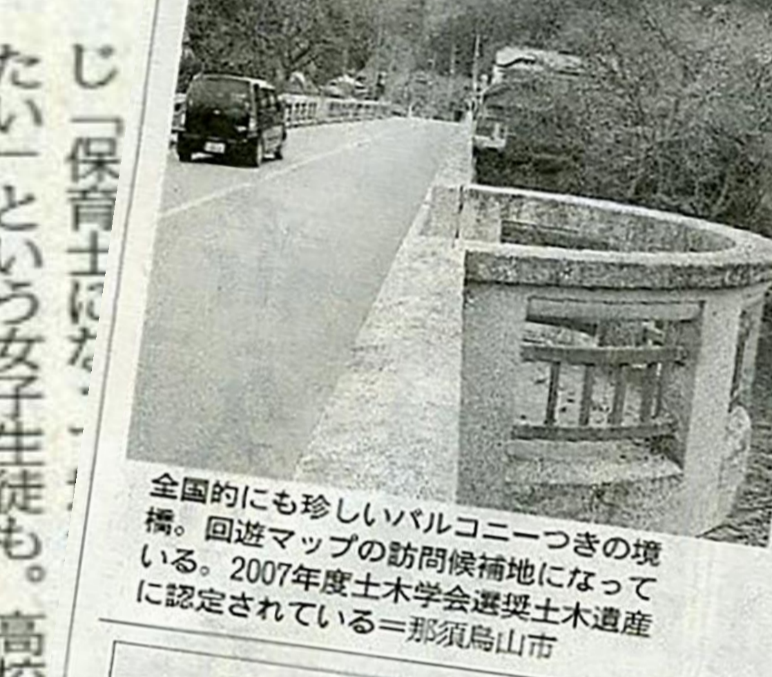
全国的にも珍しいバルコニーつきの境。回遊マップの訪問候補地になっている。2007年度土木学会選奨土木遺産に認定されている。那須烏山市
