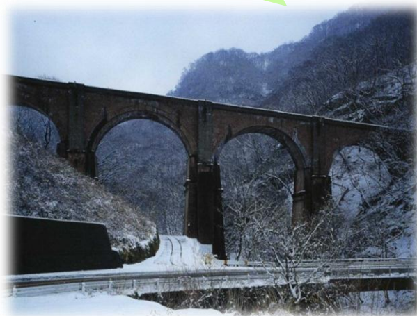
碓氷第三橋梁 (群馬県安中市)
