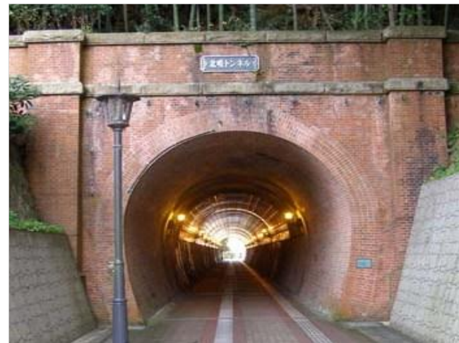
北吸トンネル（京都府舞鶴市）
