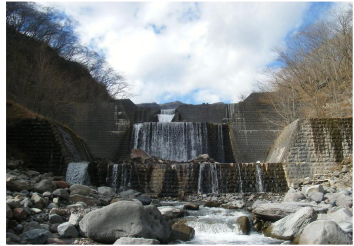
日光稻荷川流域の砂防堰堤群
