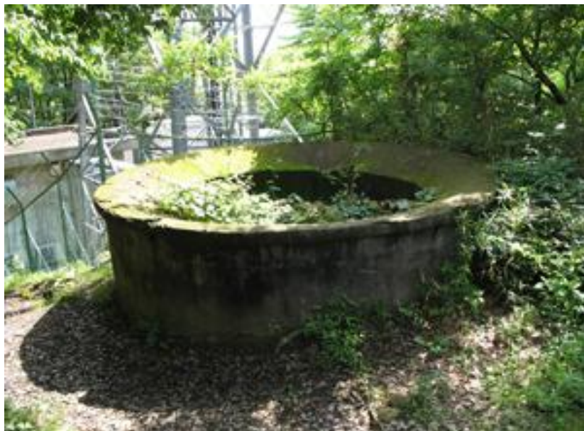
筑紫山頂に建造された烏山防空監視哨
