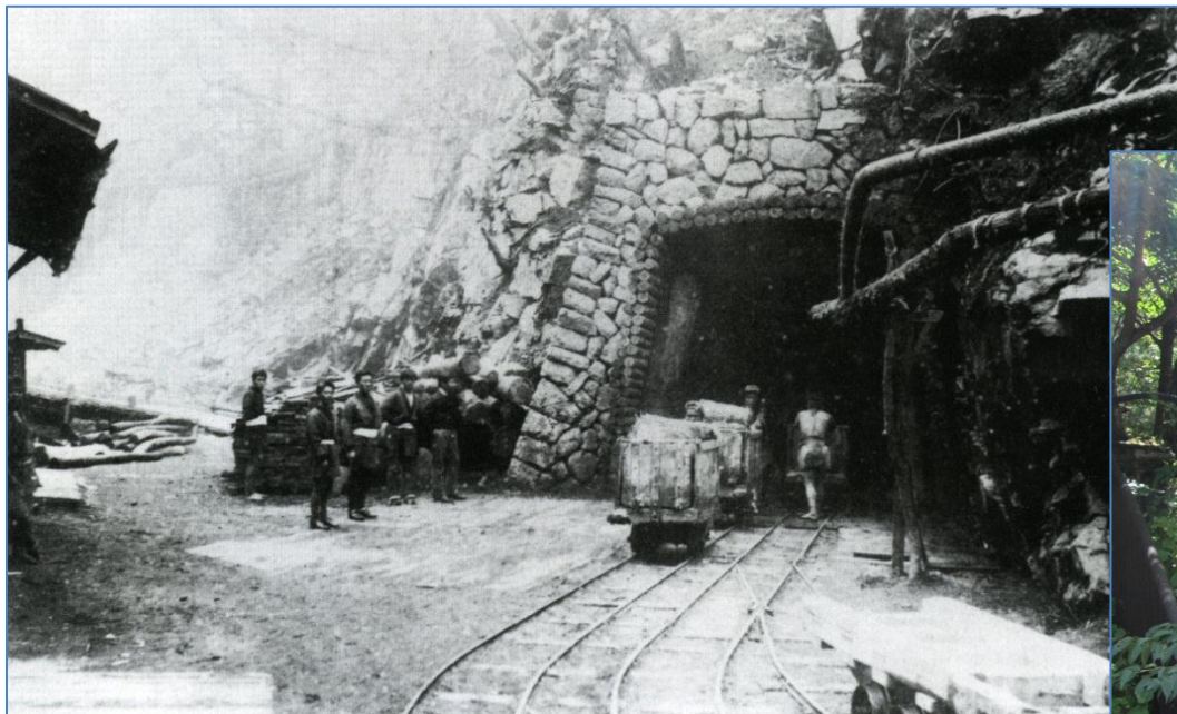
小滝橋（写真中央）と小滝坑口（写真下）
