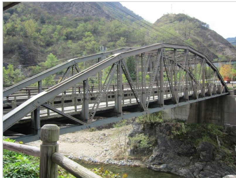
古河橋（栃木県日光市）
