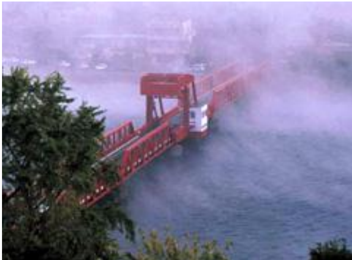
長浜大橋（愛媛県大洲市）
