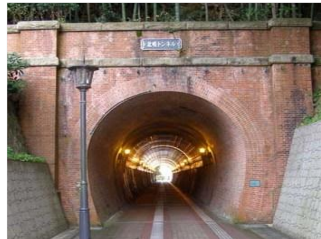
北吸トンネル（京都府舞鶴市）
