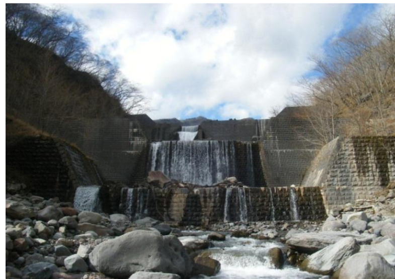
日光稻荷川流域の砂防堰堤群
