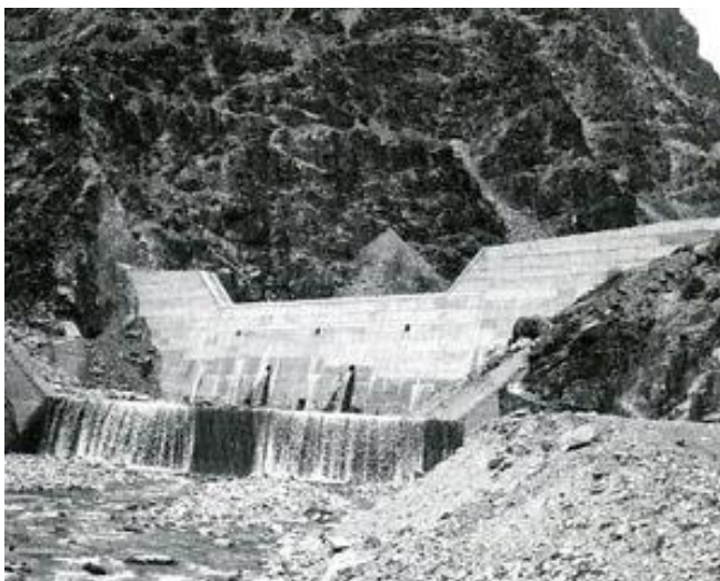
松木川1号砂防堰堤/粗石Cダム/S39.10.30完成
