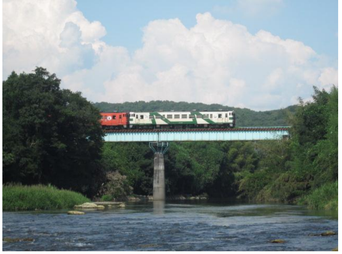
図9 現在の荒川橋梁
