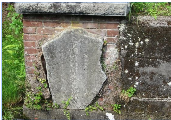
鳴沢川取水口に刻まれた社章（上）と社名・起工年・竣工年が陰刻された銘板（下）
