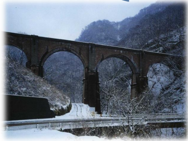
碓氷第三橋梁 (群馬県安中市)
