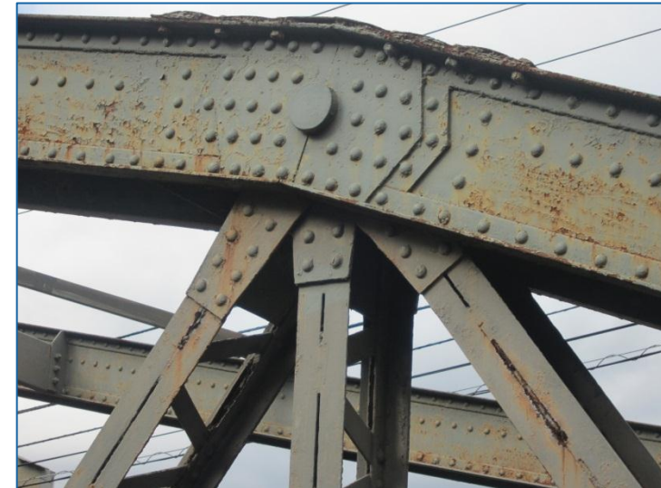
写真上：Harkort社の銘板 写真下：ピン結合の格点
