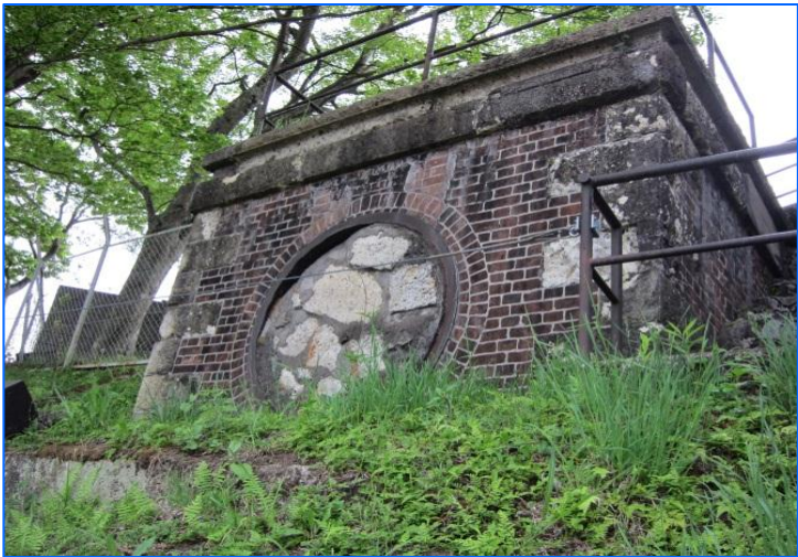
旧水圧鉄管固定台。焼過煉瓦が鈍色に輝く。
