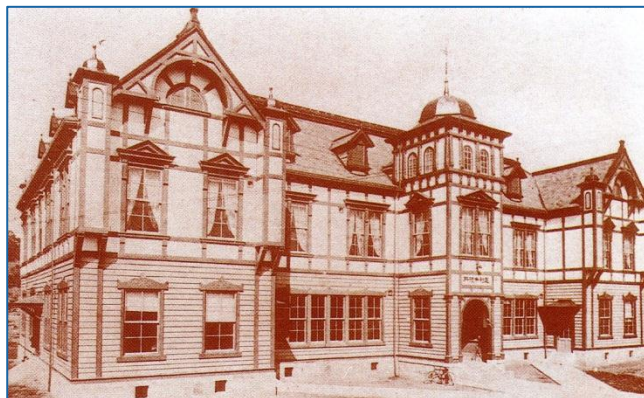
足尾鉱業所の事務所を解体移築した旧足利市役所。昭和49年6月に解体された。
