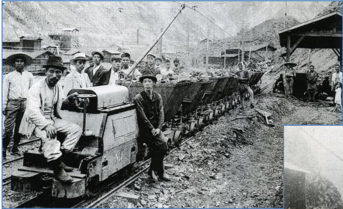
トロリーポール式電気機関車 による鉱石運搬 (明治30年)
