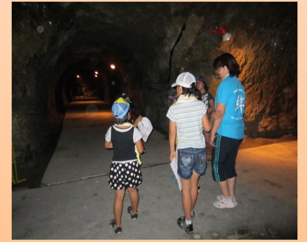
写真3 旧戦車工場での歩測による坑道長の測定(8月22日)
