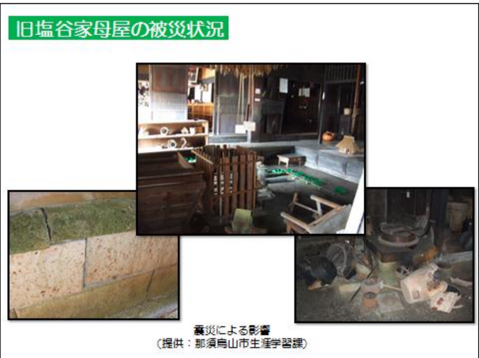
図3 旧塩谷家母屋の被災状況
