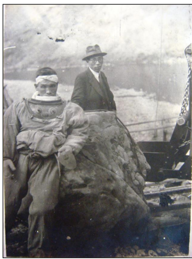
県下初の水中施工
