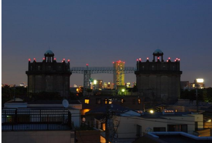
駒沢給水塔（東京都世田谷区）
