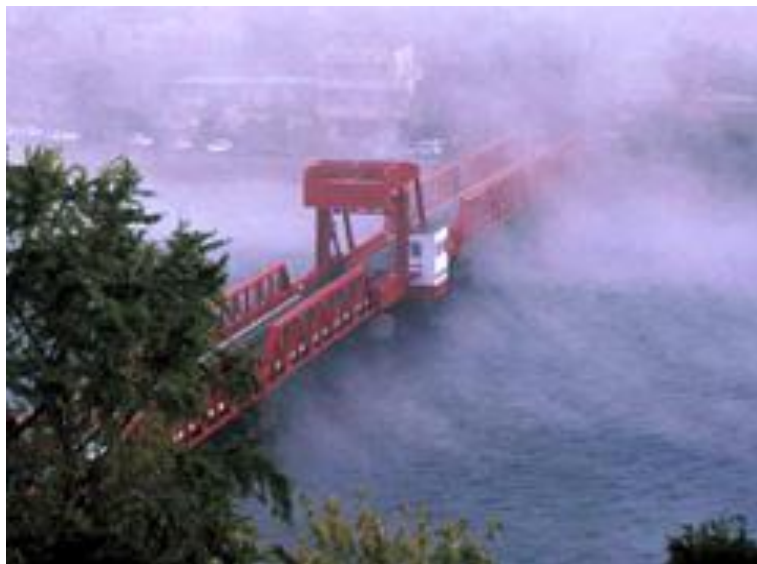
長浜大橋 (愛媛県大洲市)
