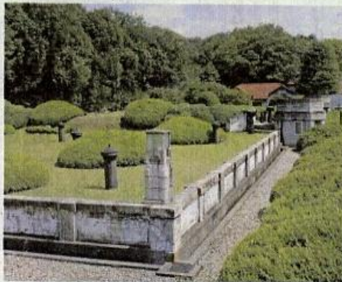
緑町配水池の配水池。奥に見える赤い屋根が水道山記念館
