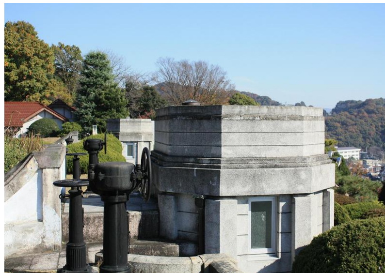
近代水道緑町配水場 (栃木県足利市)
