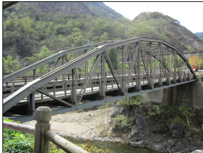
古河橋（栃木県日光市）
