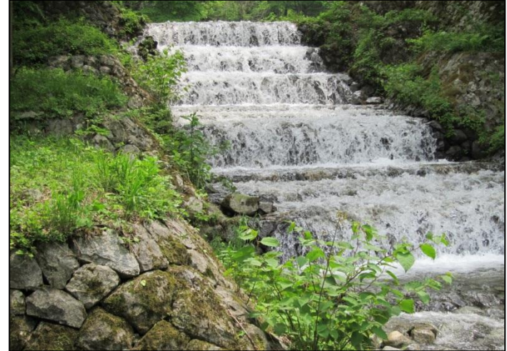
牛伏川フランス式階段工（長野県松本市）
