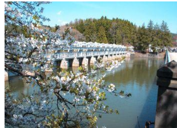
安積疏水・十六橋水門 （福島県）
