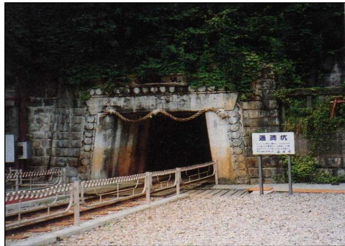
足尾銅山通洞坑口（栃木県日光市）
