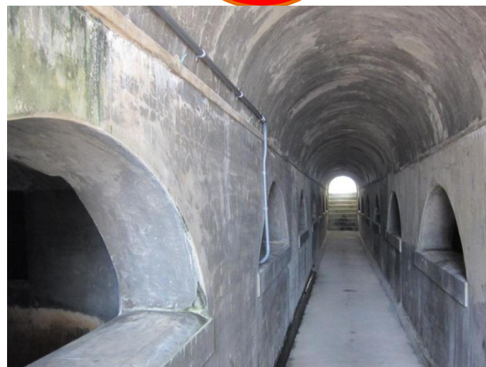
配水場の内部
