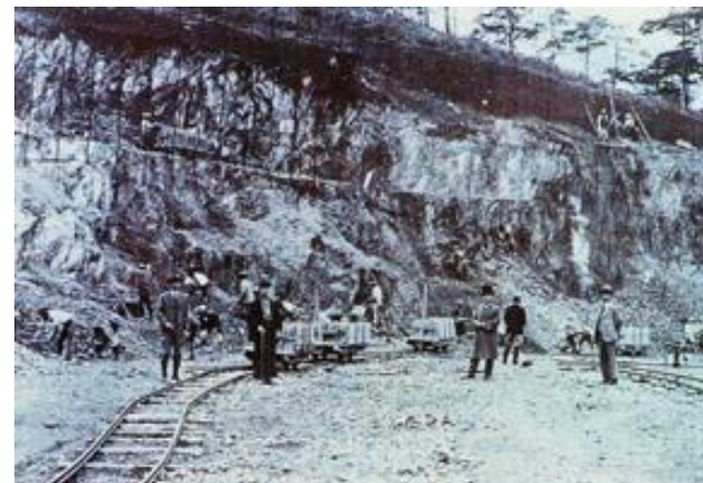
配水場建設工事（昭和4年）
