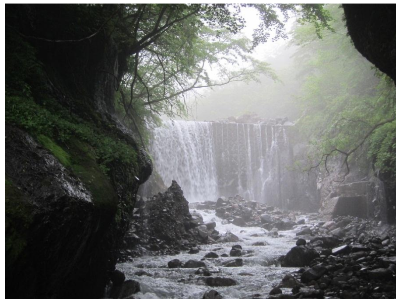
2014(平成26)年度認定の「日光稻荷川流域の砂防堰堤群」
