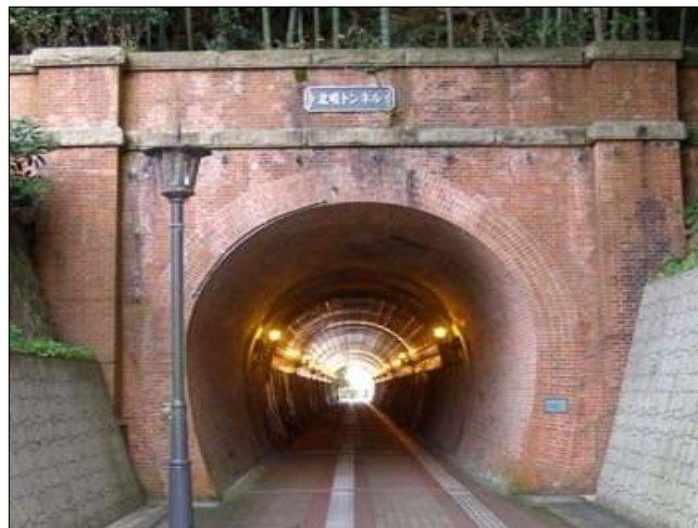
北吸トンネル（京都府舞鶴市）
