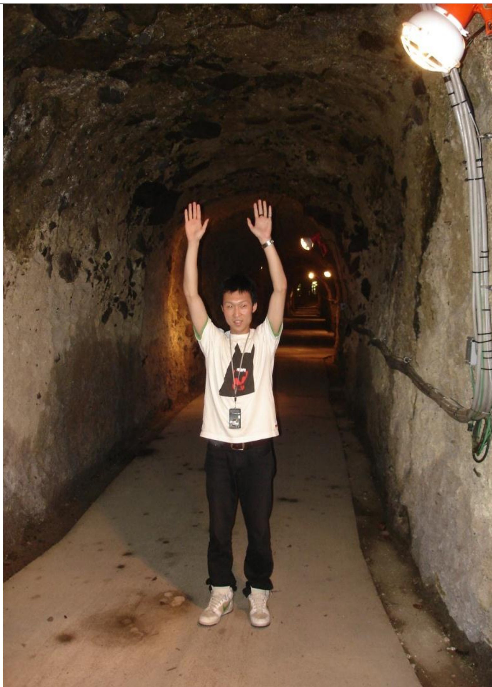
広い坑道の空間
