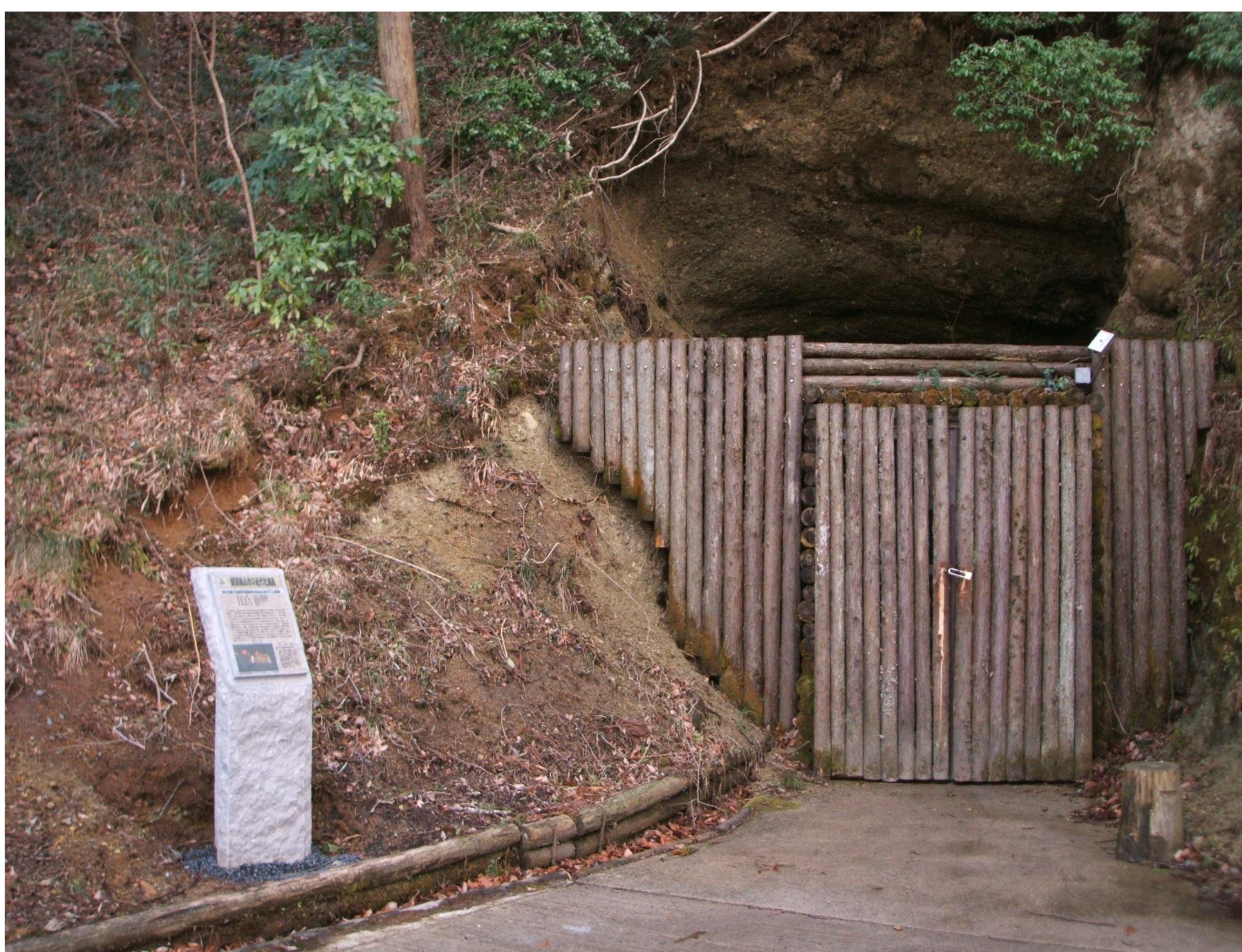
地下工場跡入口と近代化遺産解説板
