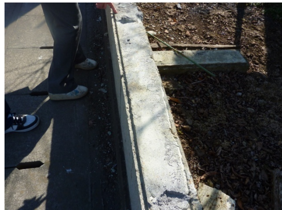
No. M-16 (真岡市原町) モルタル充填良好 (付着状態不良)
