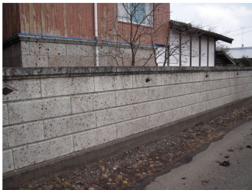
No. M-6（真岡市下籠谷） 無被害 高さ 1.72 m・鉄筋入り
