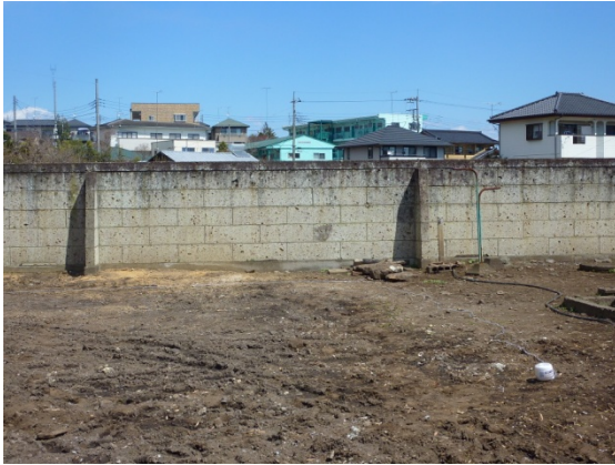
No. U-1 (宇都宮市石井町) 無被害 高さ 1.8 m・鉄筋あり 30 年前竣工
