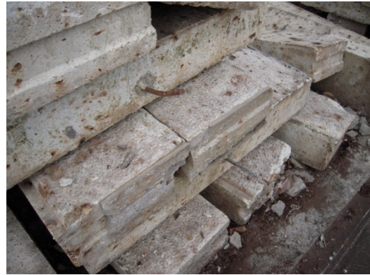
壁部の鉄筋有り
